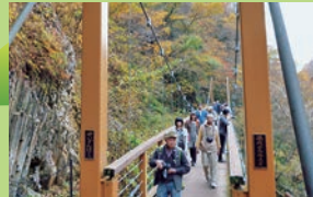
誓願橋:崩落によって失われた散策道に架けられた新しい吊り橋。
