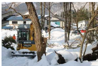
雪の重みで倒れた木(手前)と、処理作業の重機
