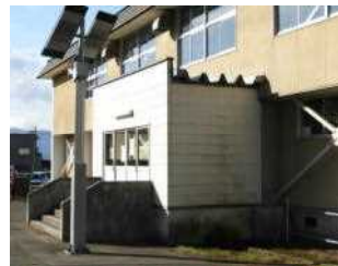
階段と白い玄関部分が 解体されます
