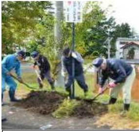
設置作業の様子
