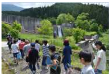
子先達川第1砂防堰堤
