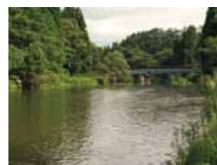
⑦月見堂橋付近
