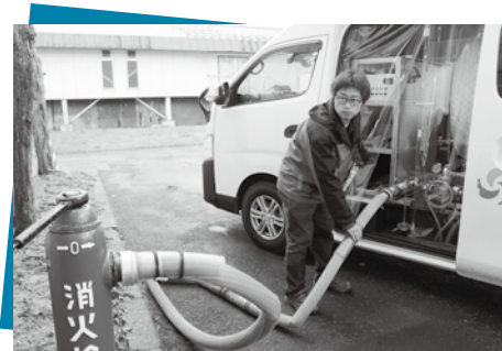
給水車に水を補充作業中。
