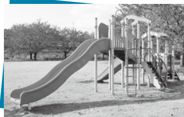
角館駅東公園の遊具。点検は欠かせません。
