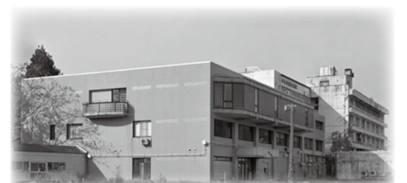
※上野庁舎として整備される旧市立角館総合病院管理棟
