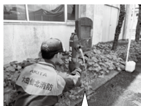
消火栓点検「異状なし！」
