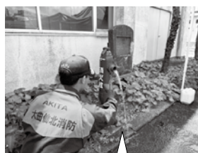
消火栓点検「異状なし！」
