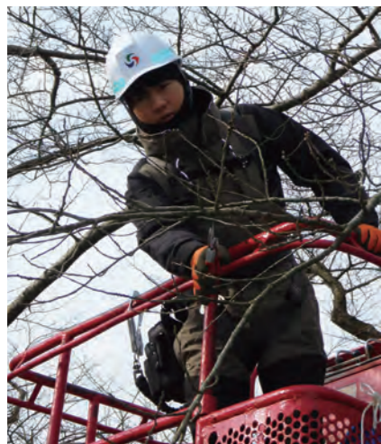
高所作業車を操り、剪定作業をする板橋朋洋技師。
