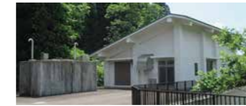
↑西明寺低区第2浄水場（平成26年建設）
