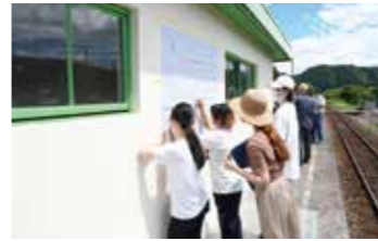
工事が行われた7月9日には工事の様子についての駅名標を下書きする学生たち。
