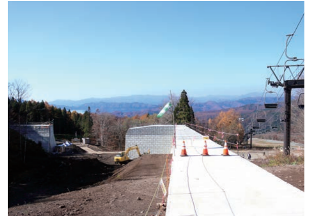
砂防堰堤上部からの様子。完成に向けて工事が進められています。
