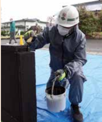
利用者に気持ちよく利用していただくため屋根や柱、イスなどを塗装しました。
