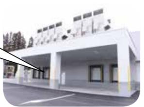
ドッグシェルターにより、運送車両と建物に気密を持たせ、外部の気象条件に左右されずコンテナの出し入れを行えます。
