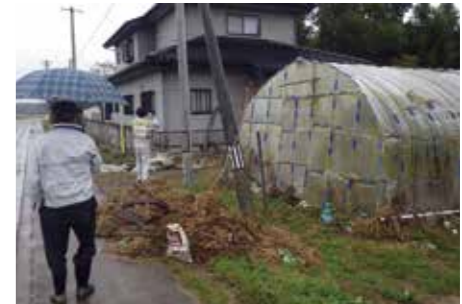
被災家屋の調査の様子(10月29日撮影)。
