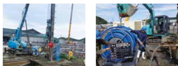
写真のような重機で地下100mまで掘削し（左）、その中に地中熱交換器を設置しています（右）。
