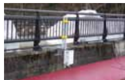
先達川に設置された水位計。
