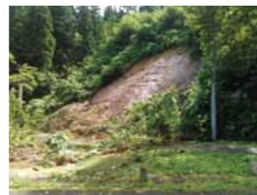
旭山神社下法面崩落(8月24日・25日の大雨で崩落)・西木町松木内字松葉
