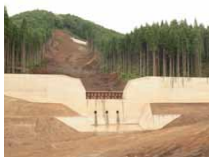
高さが10メートル、幅が121メートルの砂防堰堤が完成しました
