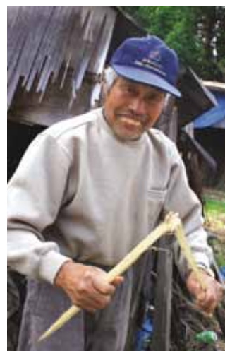
現場仕事の合間に串を作ります。串は差した茅を留めるストッパーの役割の道具。ナラの木を裂いて細くし、中心を木槌でたたいてねじりながら回転させます。女性が髪を結うときに使うUビンの要領で茅に差しします。
