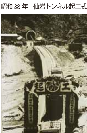
昭和38年 仙岩トンネル起工式
