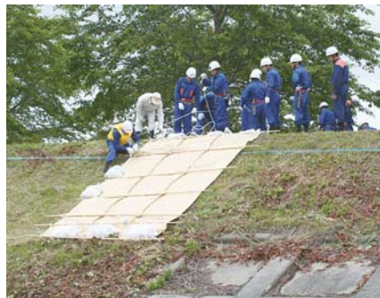
シート張り工:
