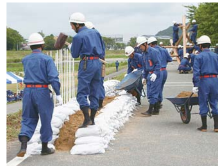
積み土のう工:
