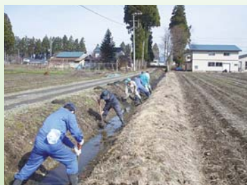
生田地区環境保全グループ 農業用水路の泥上げを定期的に行い施設を管理します。
