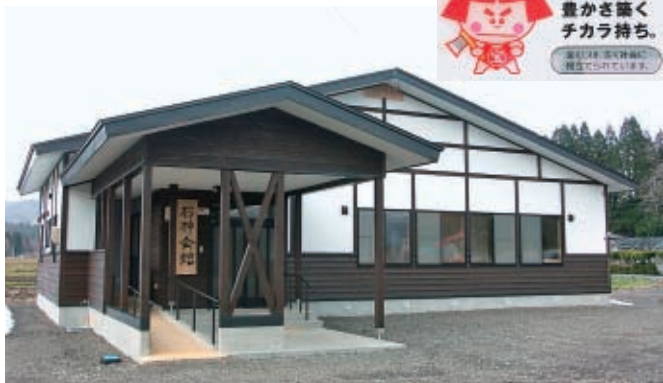
完成した石神会館
