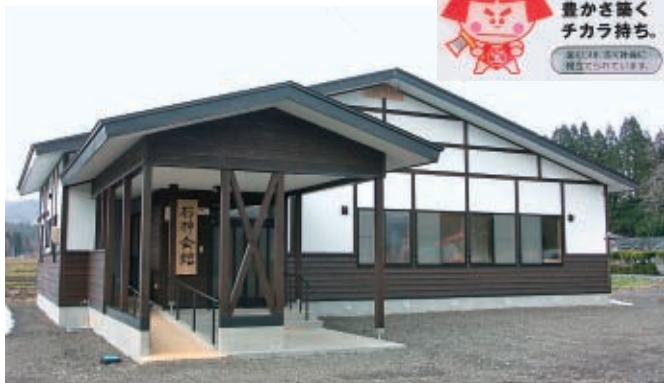
完成した石神会館
