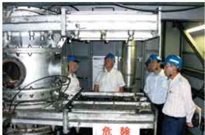
火災発生時、水をかぶったガス化炉
