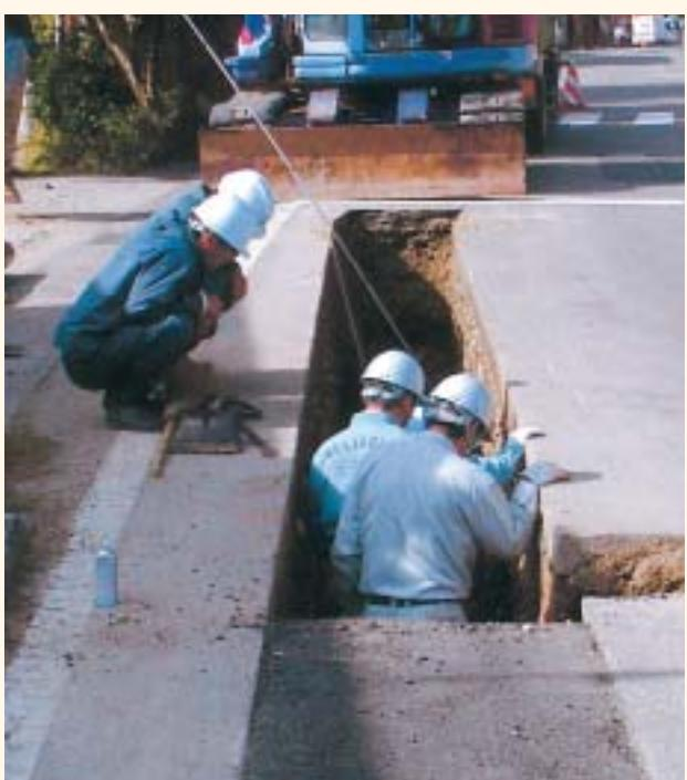
老朽管入れ替え工事
