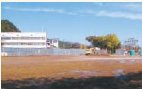
新築工事が始まった角館統合小学校
