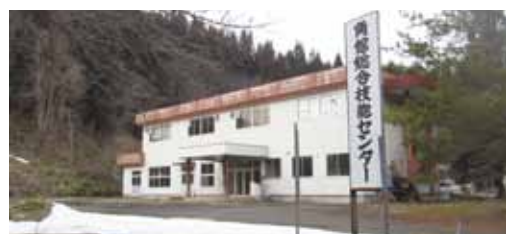
■解体予定の角館総合技能センター
