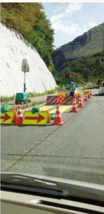
片側交互通行が続く仙岩道路
