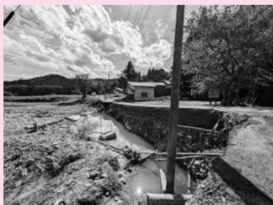
■桧木内川氾濫によりえぐり取られた路肩
