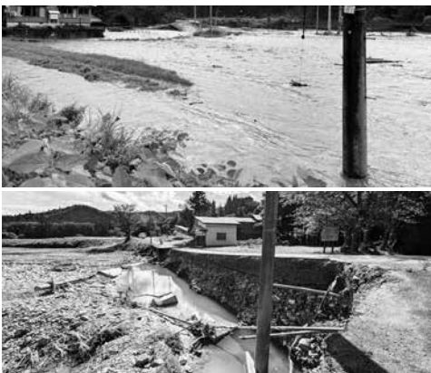
■8月の上桧木内地区を襲った大雨の状況
