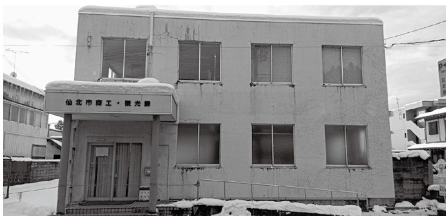
■建物を解体し土地のみの公売を検討している旧中町庁舎
