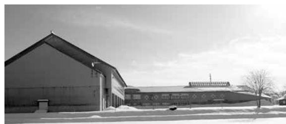
■1階をコミュニティセンター、2階をインターナショナルスクールで活用予定の白岩小学校
