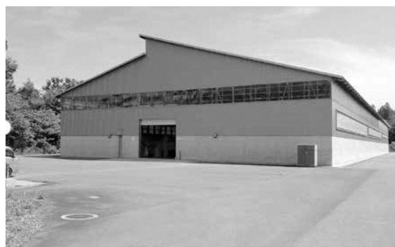
■屋根修繕を実施する堆肥センター
