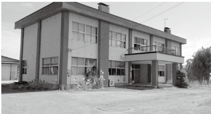
■除却が進まない公共施設（旧西明寺公民館）
