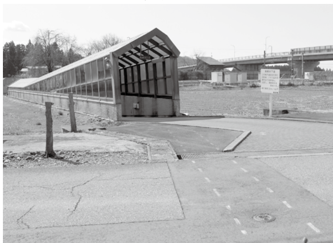
■予定を変更し水道管敷設が迂回された真崎地下道
