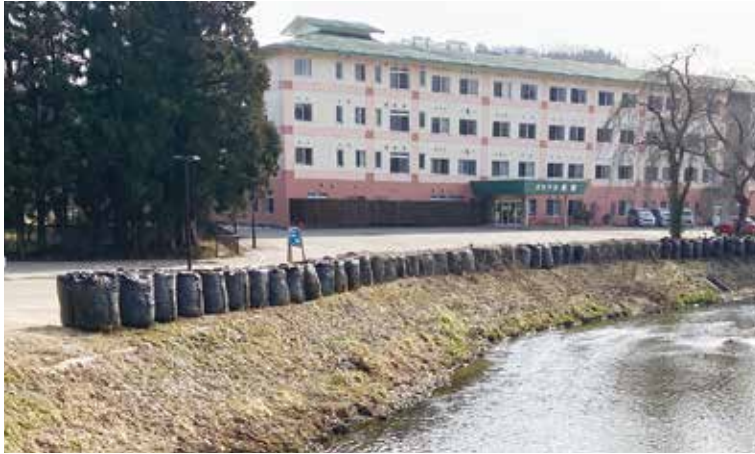
■大量の土嚢を積んで越水防止のさわやか桜館前
