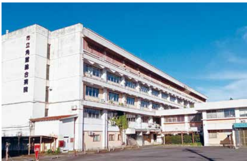
■一向に利活用や解体が進まない旧角館公立病院
