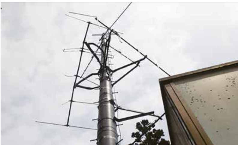
■雪で破損していた桧木内地区防災無線中継所
