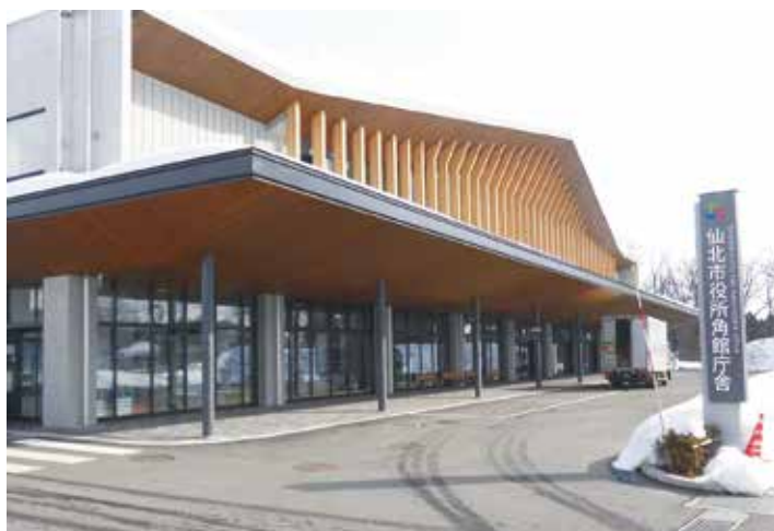
■まだまだ分庁舎方式が続く3庁舎
