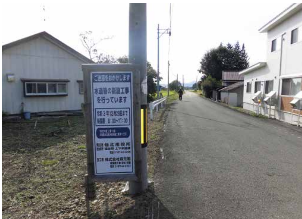
■水道工事が始まる卒田地内
