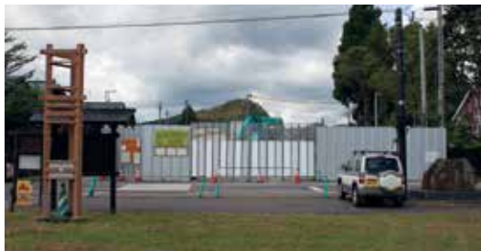
■想定以上のアスベスト含有で解体工事費が増額された旧角館庁舎
