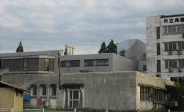
■解体が先延ばしになっている 旧市立角館総合病院（左側が管理棟）
