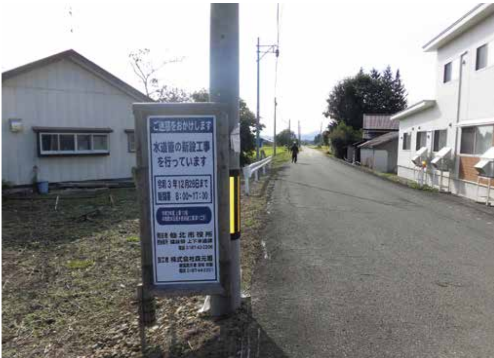
■水道工事が始まる卒田地内
