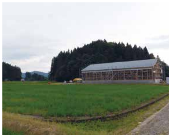
■神代地区に整備されるネギの大規模育苗施設建設予定地（建物手前）
