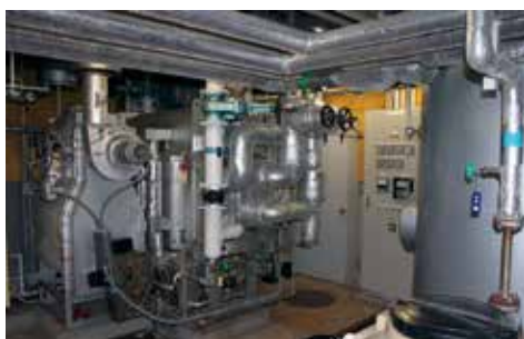
冷温水発生機が更新される 平福記念美術館
