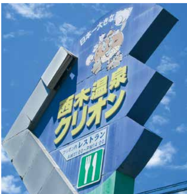
■クリオン看板が強風で破損 早い修繕対応を求める
