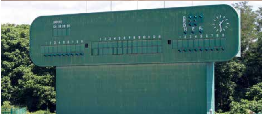
■スコアボードの電光掲示板化や、球場内にある危険な柱を撤去するなどの全面的改修が望まれている落合球場。
