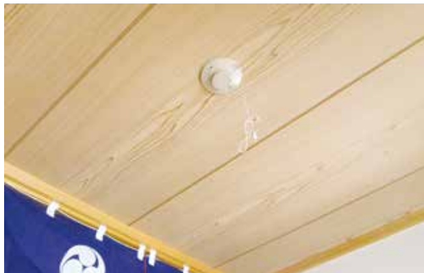
■火災による死傷者を防ぐため、高齢者のみの世帯に火災報知器の設置を求める
