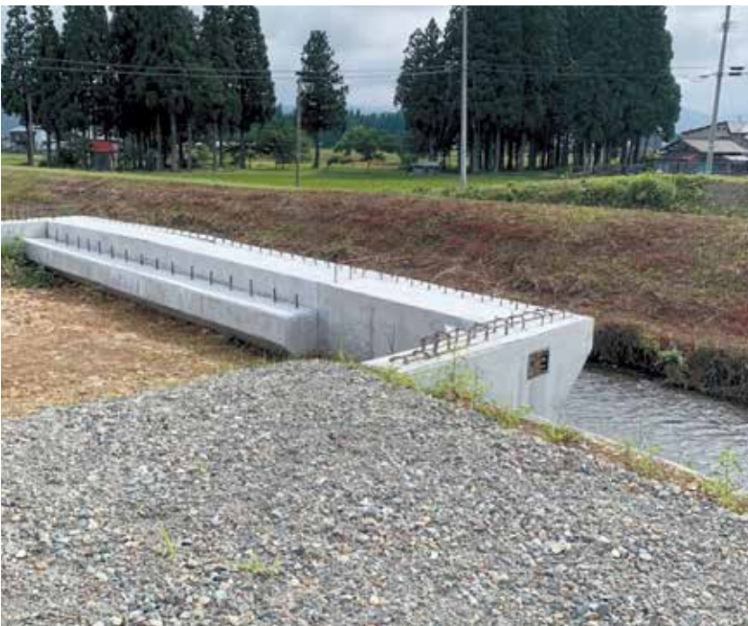
■早期の改修が望まれる神代中央線・古館野橋
