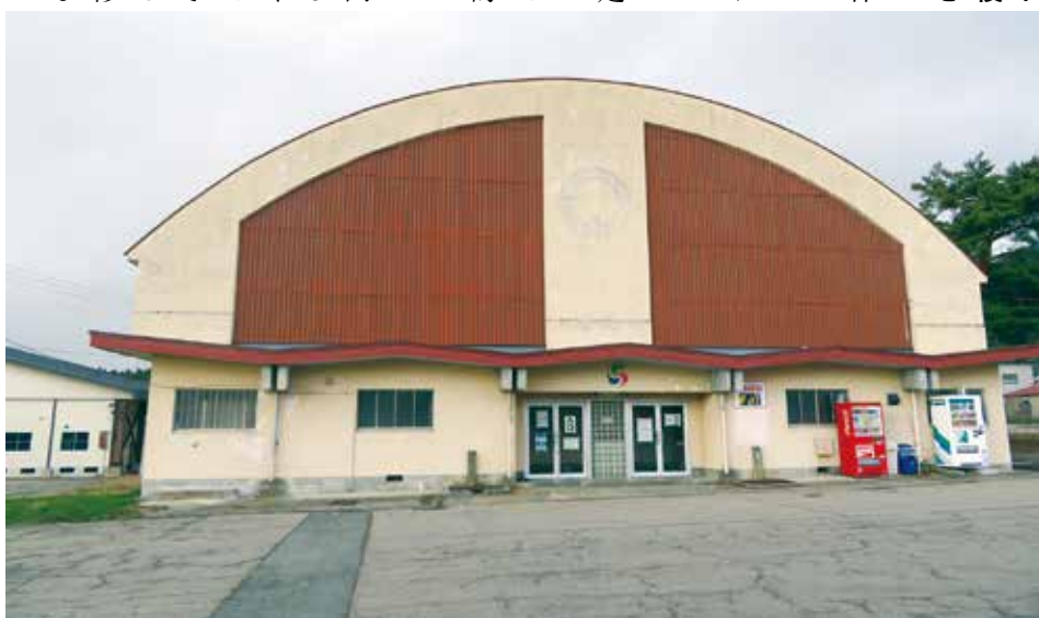
■生保内財産区から財源支援を受け改修する生保内体育館
