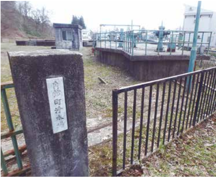
■大規模断水 不具合が生じた取水口付近
