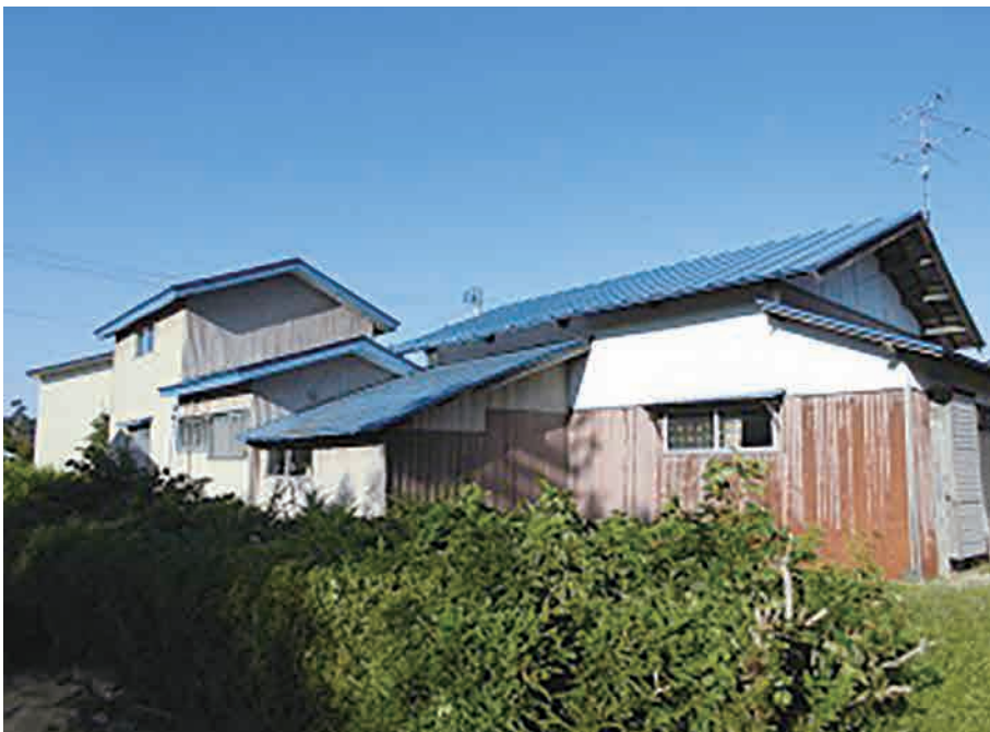
■空き家解体の支援制度見直しを
